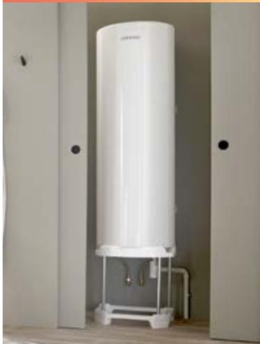
Un chauffe-eau vertical mural installé sur un trépied doit obligatoirement être fixé au mur avec des chevilles adaptées pour supporter l'appareil (conformément à la norme EN 60-335-1 article 20).
