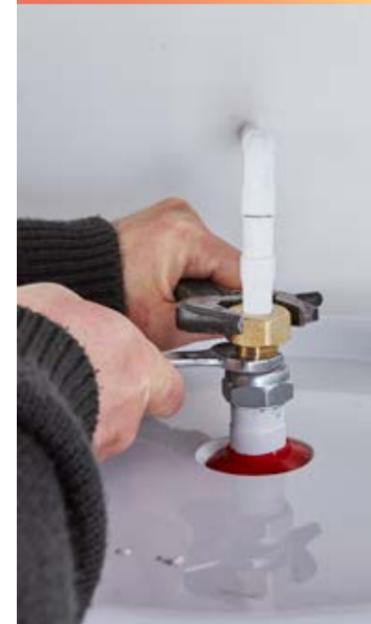
Il est impératif d'installer un raccord diélectrique en sortie d'eau chaude du chauffe-eau, afin d'éviter la corrosion de la tubulure (contact direct fer/cuivre). Les raccords en laiton sont interdits à ce niveau (DTU 60.1).
