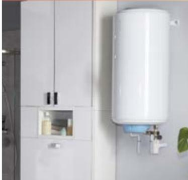
Un chauffe-eau doit être installé dans un local hors gel qui ne descend pas en dessous de 4 °C\* toute l'année.
