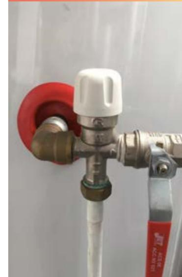
Dans le cas d'installation de tuyaux en matériau de synthèse (PER, multicouche), il est obligatoire d'installer ce limiteur de température directement sur la sortie d'eau chaude du chauffe-eau, afin de répondre au DTU 60.1 chapitre 5.2.5.
