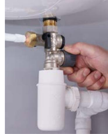
Un groupe de sécurité (non fourni avec le chauffe-eau) conforme à la norme NF EN 1487 doit impérativement être raccordé sur l'entrée d'eau froide du chauffe-eau.
